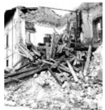
NELLA FOTO: CASA CROLLATA A COLLARANO
